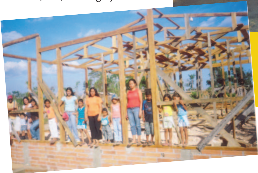
Construção do templo definitivo
